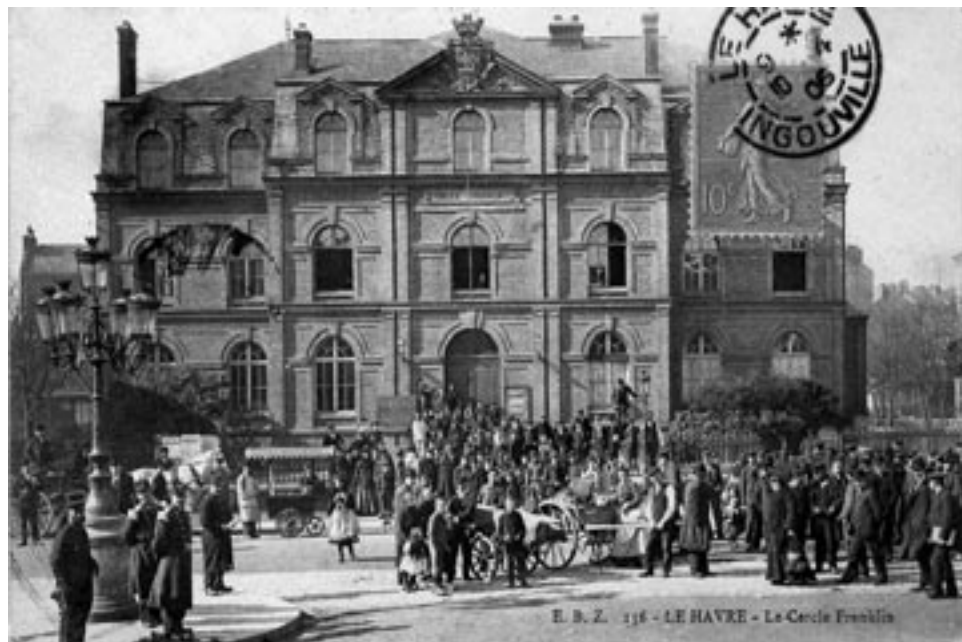
Le cercle Franklin, construit en 1872 sous le mandat du maire de l'époque, Jules Siegfried. En 1898, le bâtiment devient officiellement la Bourse du Travail, suite à sa mise à disposition pour les syndicats par la municipalité de l'époque. Cette photo n'est pas datée mais a dû être prise entre 1903 et 1924 si l'on se réfère au timbre de 10 centimes « La sèmeuse lignée »
