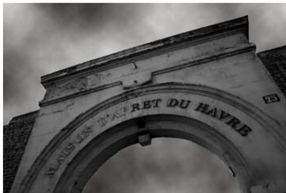
Entrée de la maison d'arrêt du Havre
